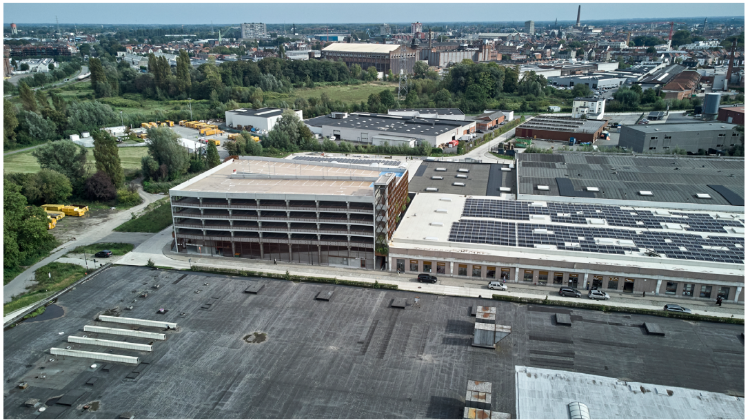
U-Connect en het parkeergebouw het Getouw, met daarachter het groene stuk waar de Wissenhagestelplaats gepland is.
