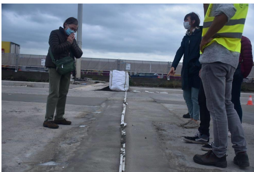
Werkbezoek door ViaduKaduk leden van de lopende renovatie van het viaduct. De bewoners evalueren de nieuwe voegen. (2020)
