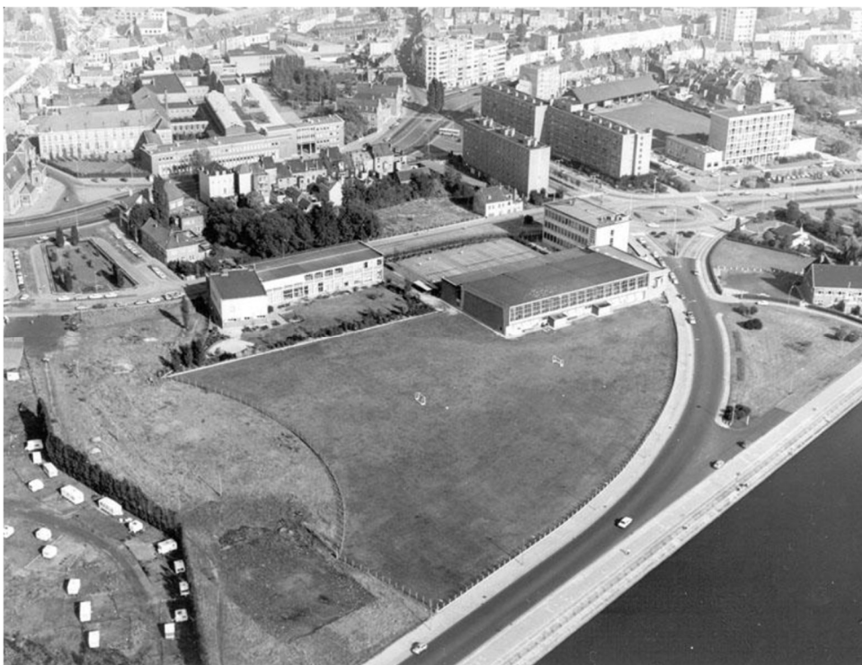
Figuur 1 Luchtfoto van het HILo aan de Watersportbaan en de faculteit Psychologie en Pedagogische Wetenschappen in de Dunantlaan voor de bouw en opening van de nieuwe facultaire gebouwen in 1973 (Universiteit Gent, z.d.-b)
